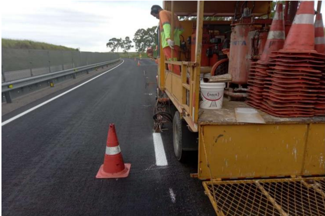
FOTO 01 – Pintura de Faixas – Km 45+000 Norte
