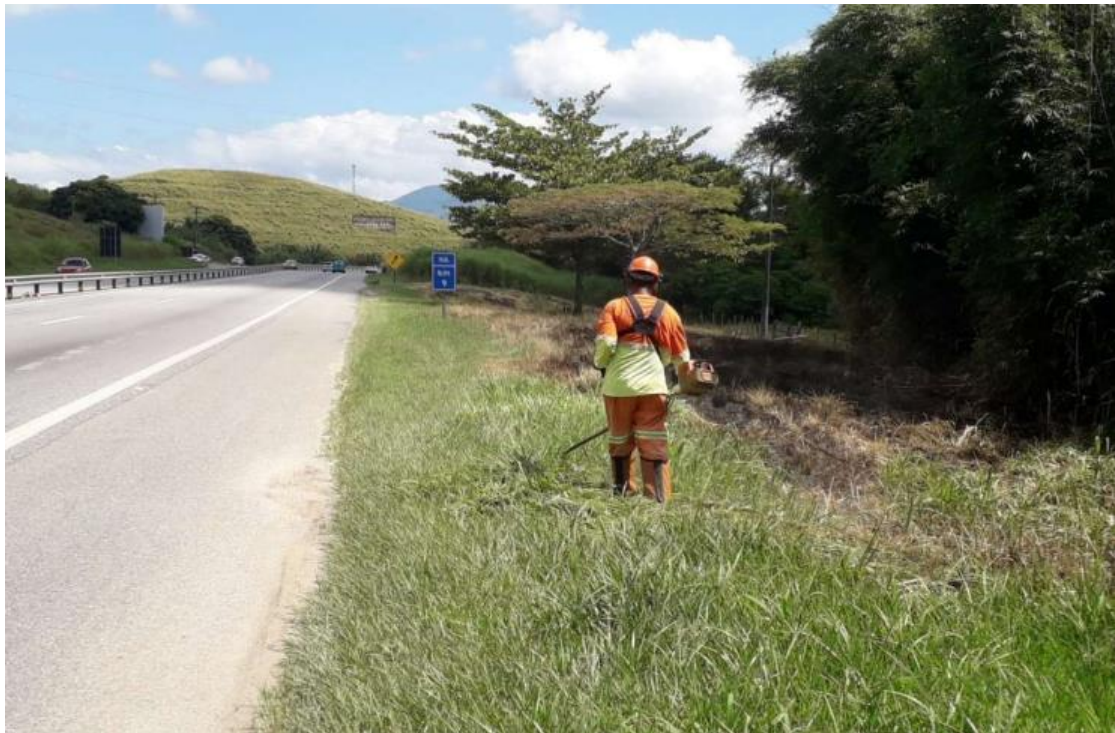
FOTO 10 – Roçada Manual – Km 9+000 Sul
