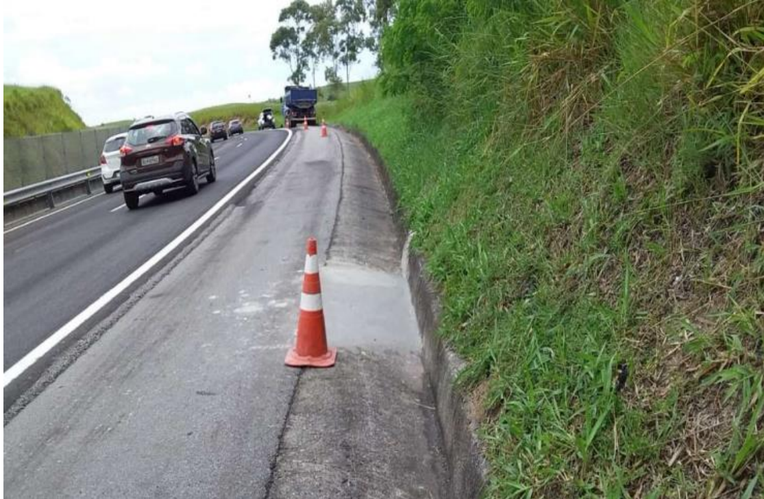
FOTO 09 – Reparo de Sarjeta – Km 45+000 Norte [2]
