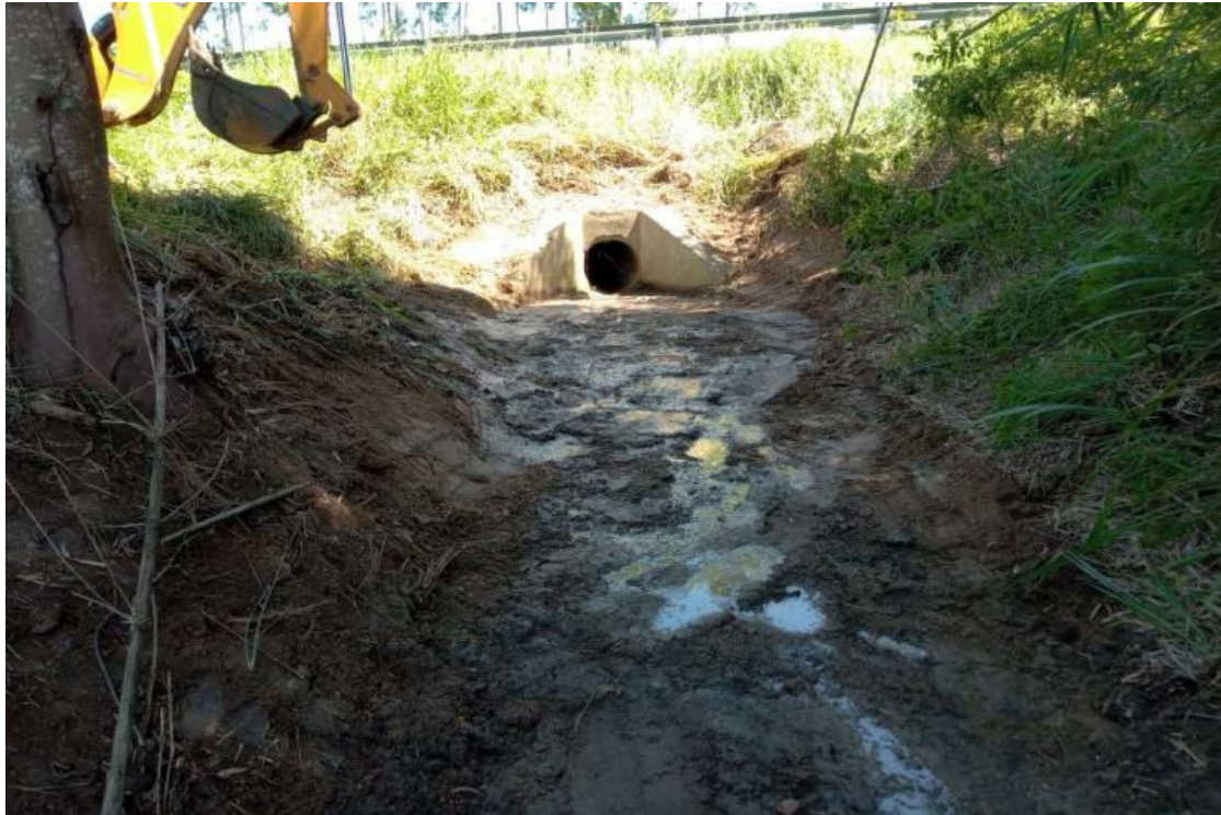
FOTO 07 – Limpeza de Bueiro – Km 44+400 Sul [2]
