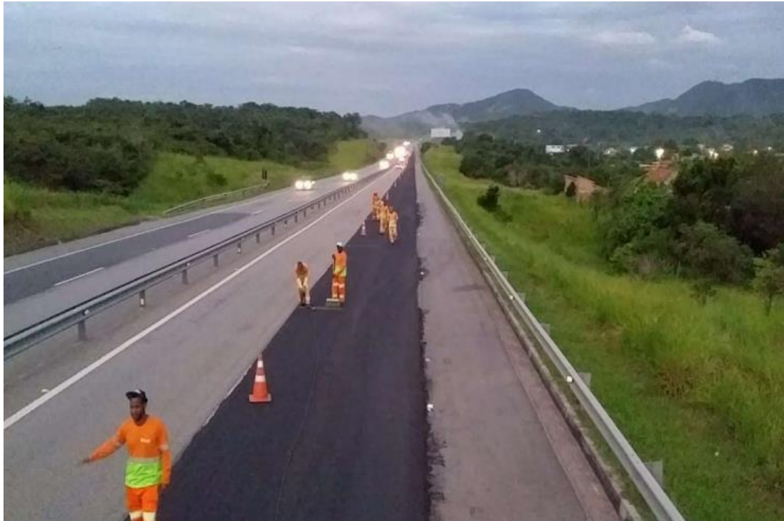
FOTO 03 – Implantação de Tachas – Km 49+000 Sul
