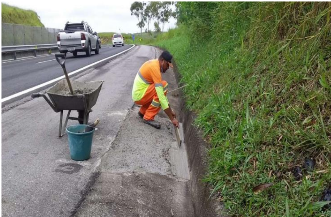
FOTO 08 – Reparo de Sarjeta – Km 45+000 Norte [1]
