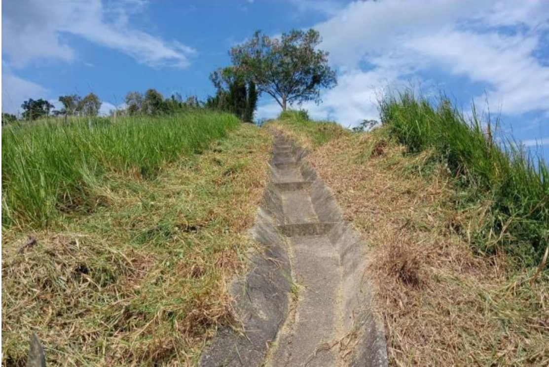
FOTO 05 – Limpeza de Valeta de Corte – Km 15+700 Norte
