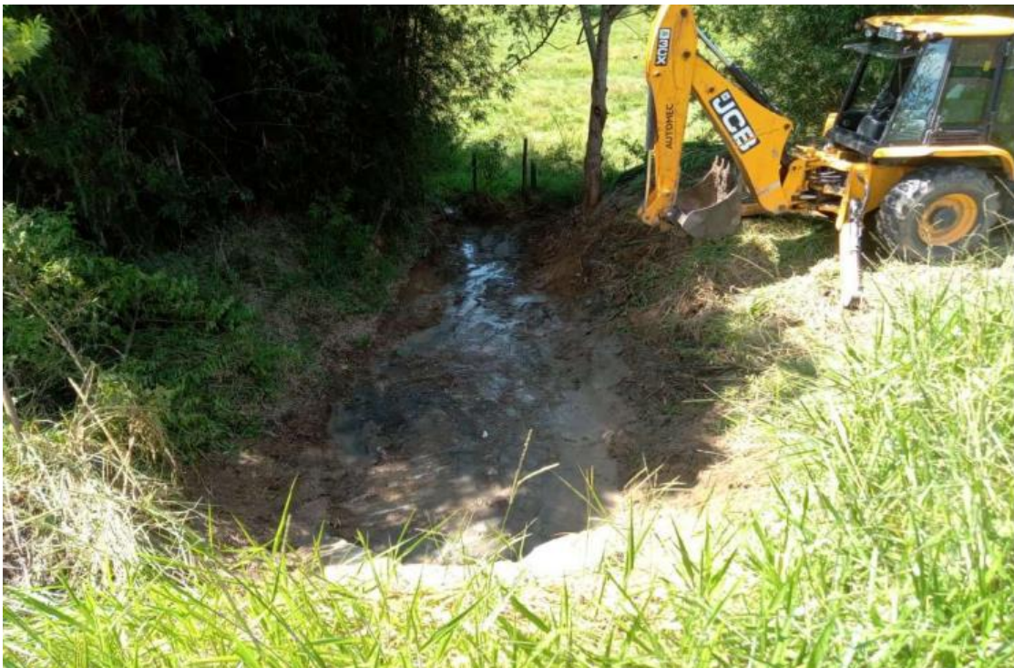
FOTO 06 – Limpeza de Bueiro - Km 44+400 Sul [1]
