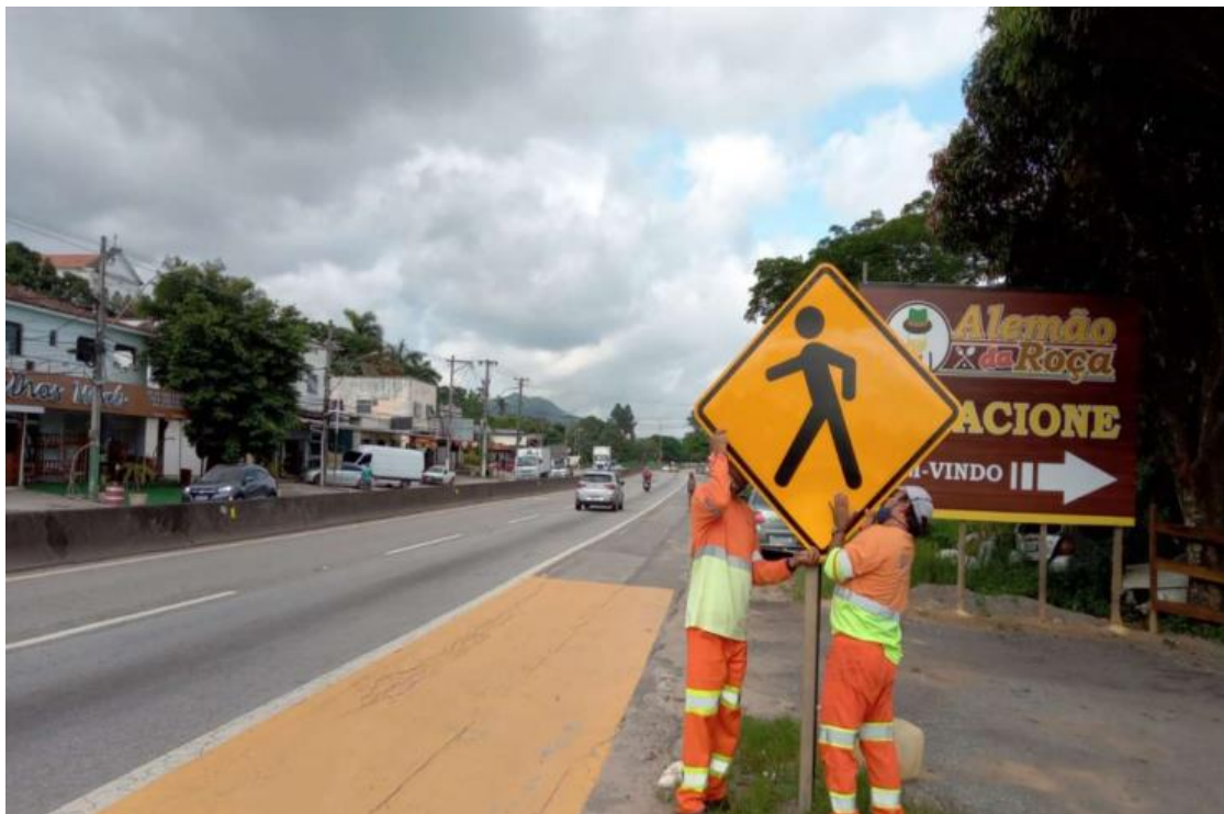
FOTO 02 – Substituição de Placa – Km 13+100 Sul
